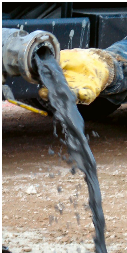
Überlauf der Mischzone Wasser/ThermoCem.
