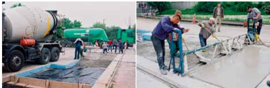
Bild 1: Betonage der Versuchsfläche im Zementwerk Mainz-Weisenau
