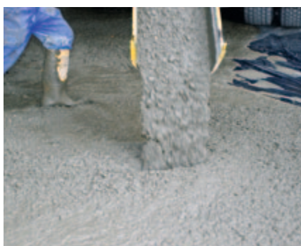
← Betonage der Bodenplatten z. B. mit Steelcrete.
