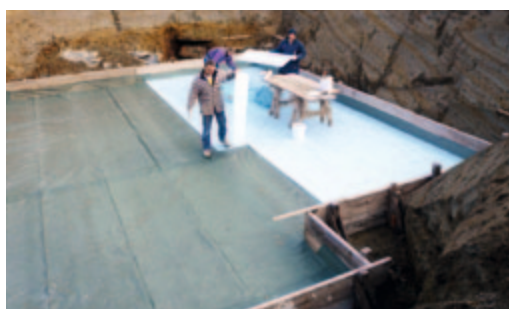
← Auslegen der Dämmplatten.
