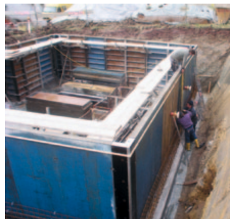
Aufstellen der → Schalung.
