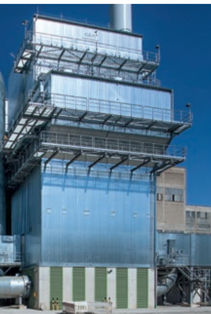
↑ SCR-Anlage zur Reduzierung der NO x -Emission.
