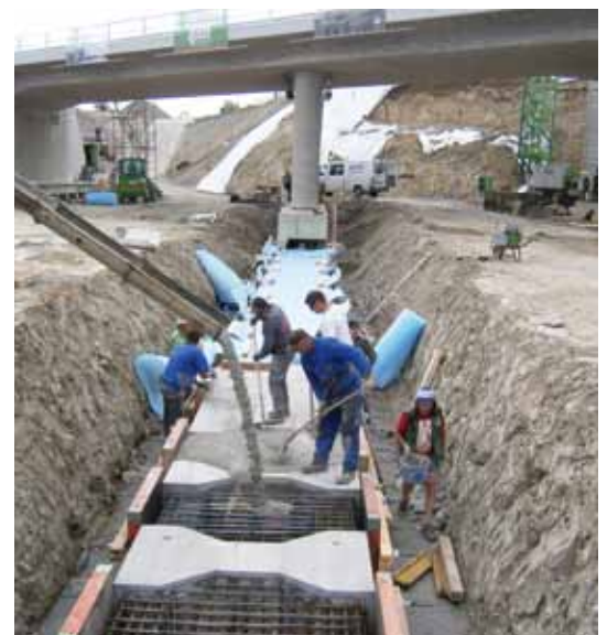
↑ Betonage einer Querverschubbahn mit Chronocrete
