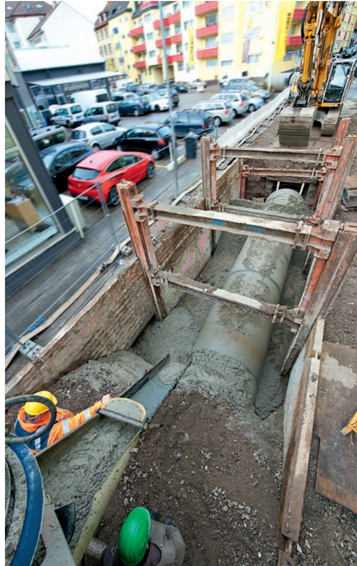
↑ Durch die mögliche schmalere Grabenbreite ist nur ein geringer Aushub nötig.
