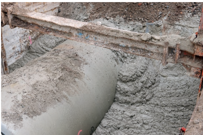
← TerraFlow ermöglicht eine längere Lebensdauer der Rohre bzw. Leitungen durch die hohlraumfreie Ummantelung und die damit bessere Bettung.
