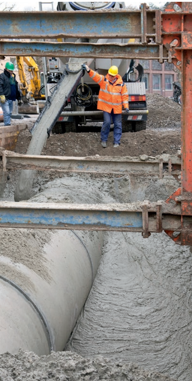
↑ Die Stadtentwässerung Pforzheim (ESP) erneuerte die über 100 Jahre alten Rohrleitungen der Altstadt und setzte als Verfüllmaterial TerraFlow ein.
