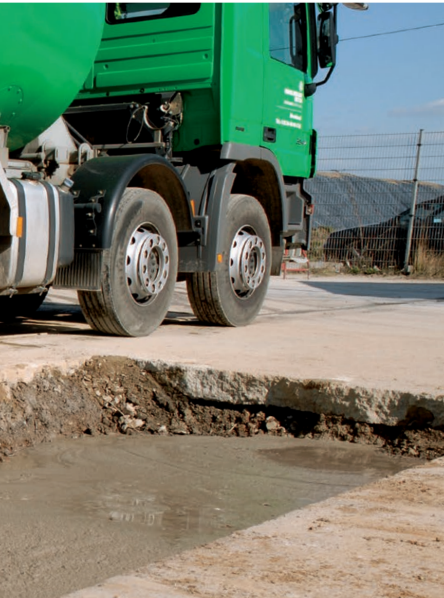
Der fließfähige Verfüllbaustoff wird direkt mit dem Fahrermischer geliefert und kann sofort eingebaut werden.
