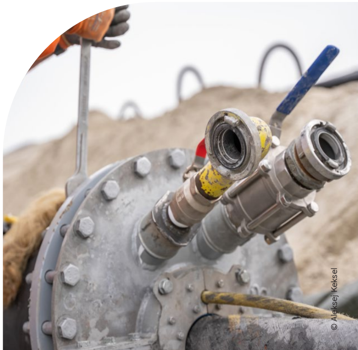
Ringraumverfüllung mit Silo (für größere Mengen)
