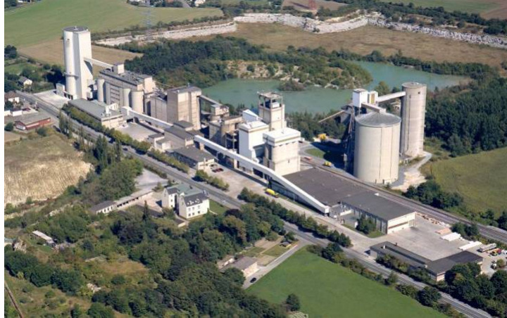
Pulverförmige Baustoffe (Sackware, Big Bag, Siloware)
