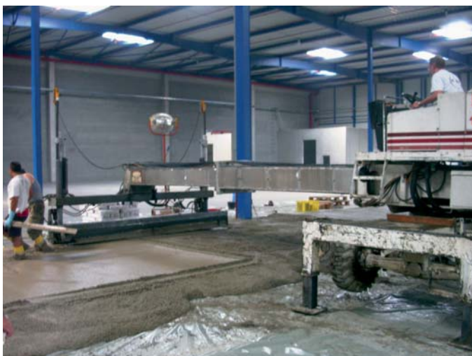
Bild 2: Betonage eines Industriebodens
