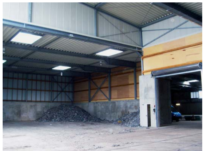
Bild 3: Biomüllkompostanlage, Bodenplatte und Wände ausgeführt in Steelcrete
