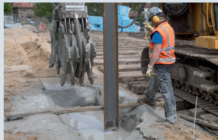
↓ Einbringung der Stahlträger in den frischen Schlitz.
